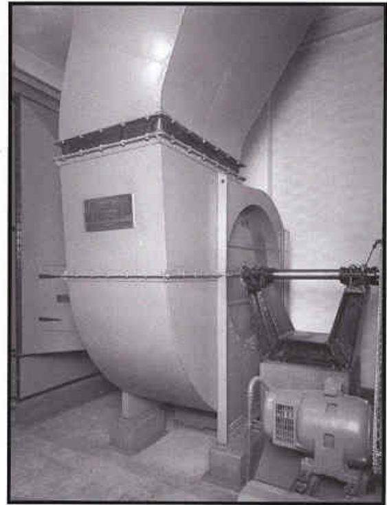
Right: Centrifugal supply air fan
